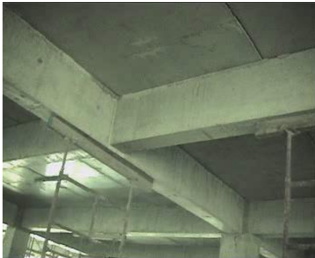
Gambar 2.10 Hasil pada sambungan balok dengan balok Sumber: Juklak PT. PP Persero (2014)
