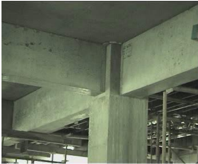
Gambar 2.11 Hasil pada sambungan Kolom Sumber: Juklak PT. PP Persero (2014)
