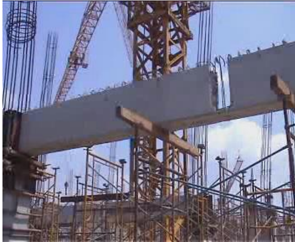
Gambar 2.9 Sistem sambungan dengan balok anak Sumber: Juklak PT. PP Persero (2014)
