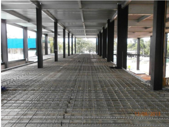
Gambar 2.7 Aplikasi Steel Deck untuk komposit beton plat Sumber: Dokumentasi proyek (2013)
