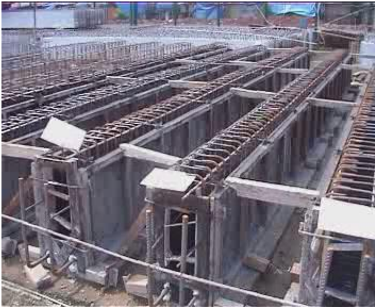
Gambar 2.2 Produksi Precast U-Shell Sumber: Juklak PT. PP Persero (2014)
