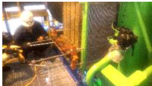
Gambar 3.12 Pemasangan CAC lanjutan
