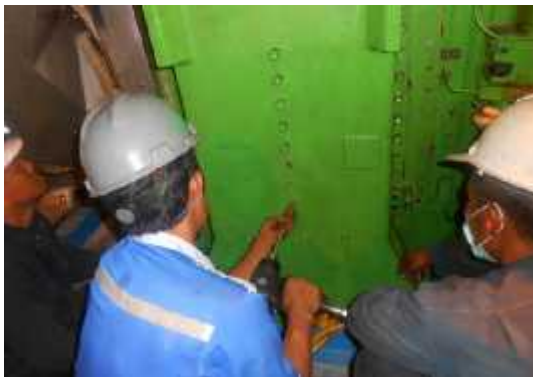
Gambar 3.13 Pemasangan CAC lanjutan
