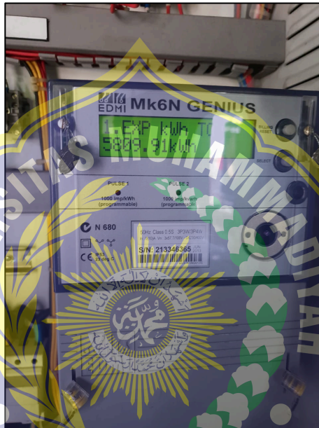
Gambar 3.8 kWh meter produksi
