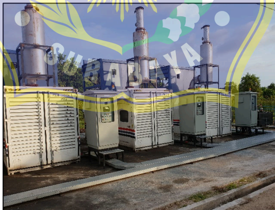
Gambar 3.1 Mesin pembangkit PLTD Kuala Pembuang
