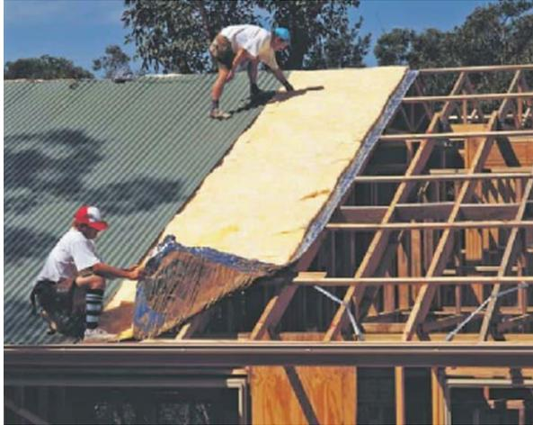
Gambar 4. Cara Pemasangan Lapisan pada Atap
