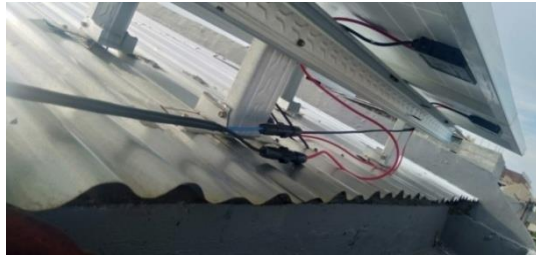
Gambar 4.3 Pemasangan kabel PV dengan panel surya (Sumber:peneliti,(2020))
