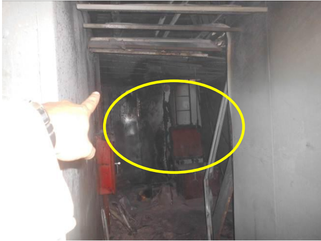
Kondisi setelah terbakar luar musholla dekat "small head"
