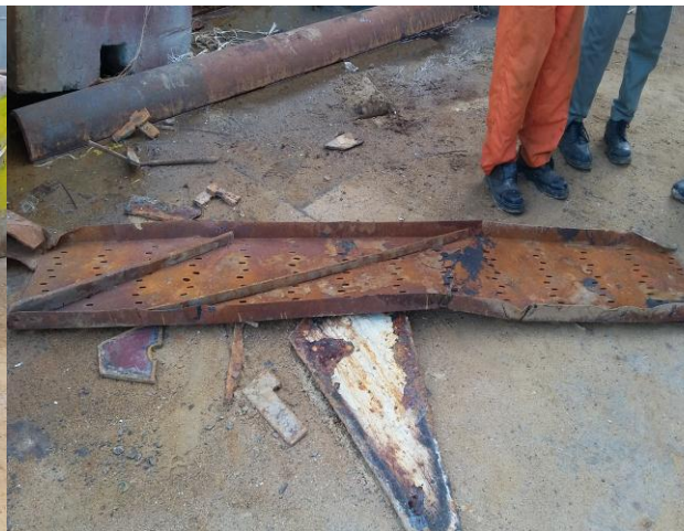
Kondisi Tulangan Penyangga Plat
