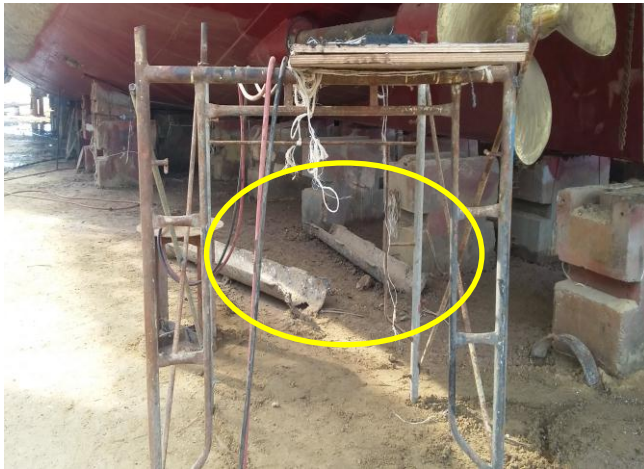
Kondisi setelah scaffolding
