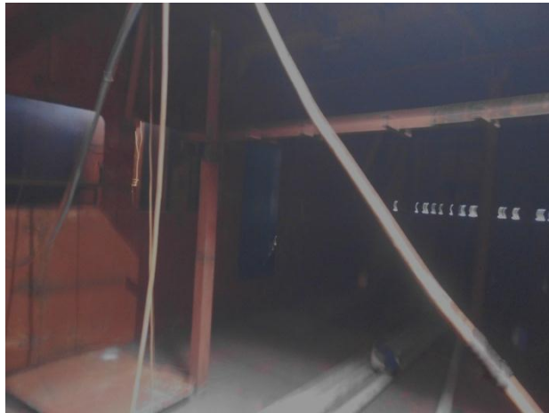
Area kerja yang kurang pencahayaan (Reka ulang)
