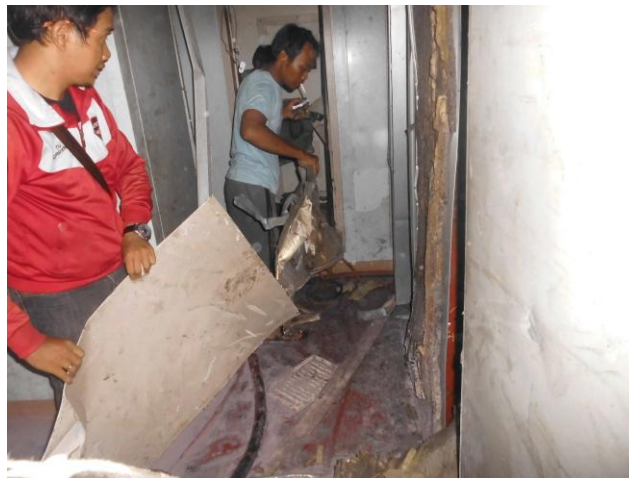
Pintu kamar mandi yang terlempar karena ledakan
