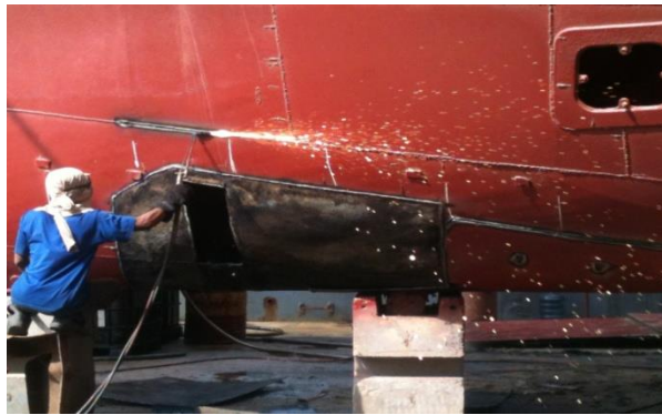
Gambar 2.6. Proses pelepasan plate
