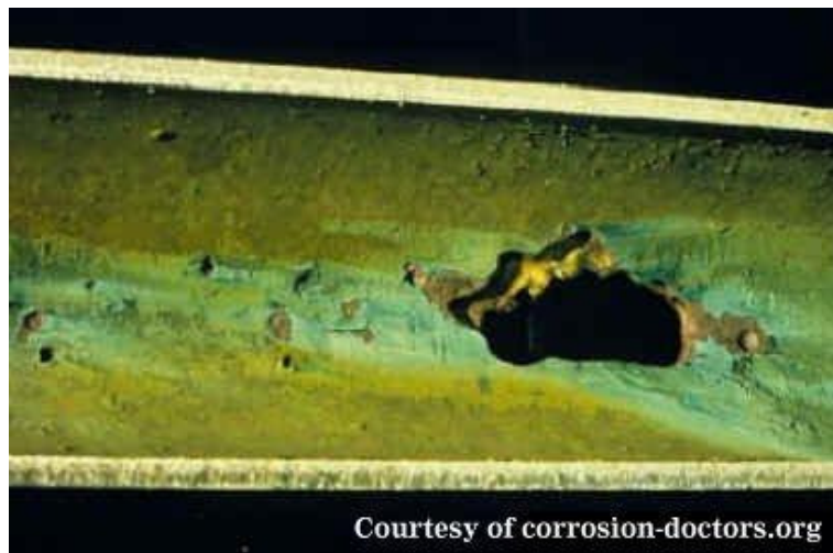
Gambar 2.17 Korosi erosi pada pipa air laut (Sumber : Korosi, Kenneth r. Trethewey, 1991)
