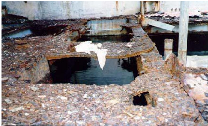
Gambar 2.10 Korosi merata pada logam (Sumber : Korosi, Kenneth r. Trethewey, 1991)
