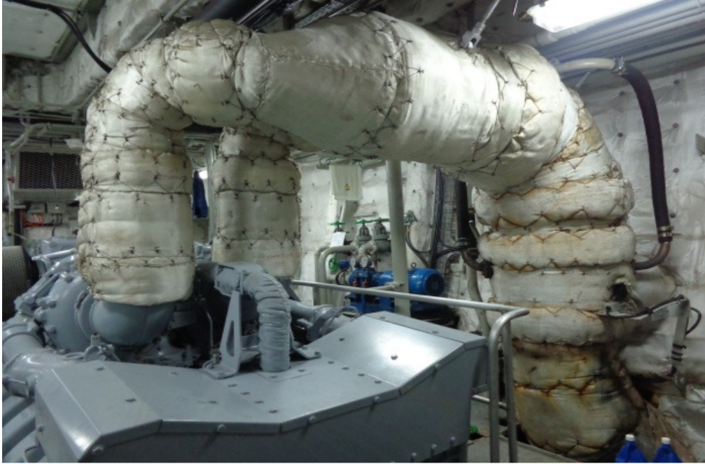
FOTO EXHAUST GAS SEBELAH KIRI
