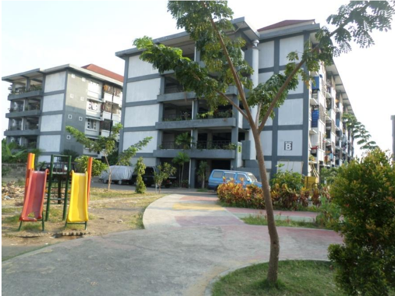
Gambar 3.1. gedung terpadu Rusunawa Tanah Merah II
