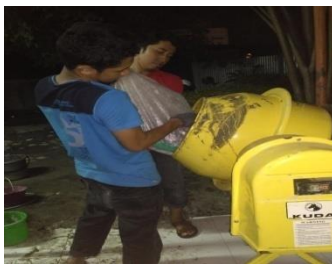
Proses Memasukkan Material kedalam Molen
