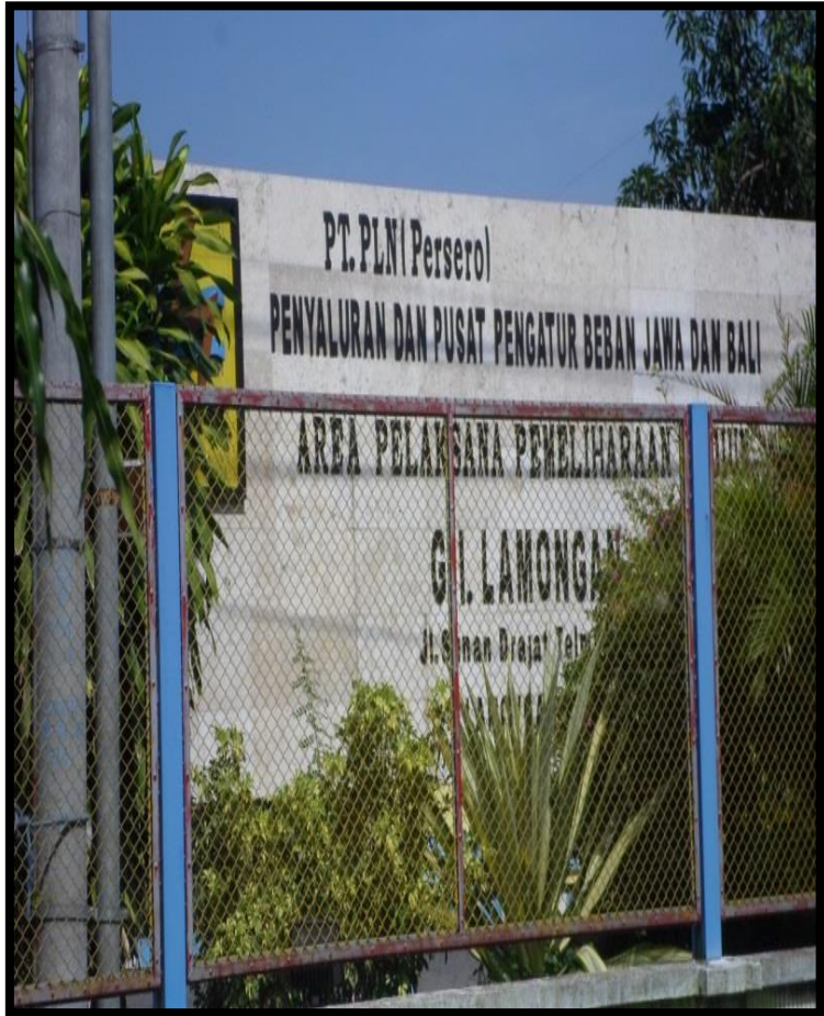
3. Foto lokasi Gardu induk 150 kV di Lamongan
