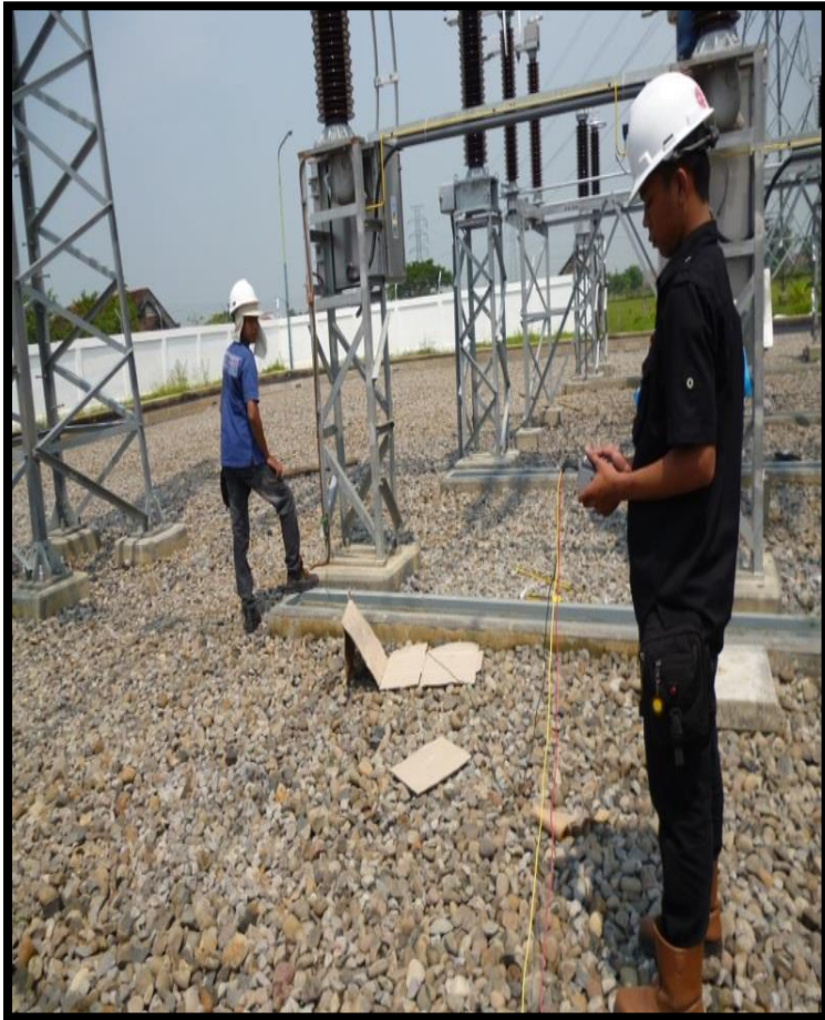
4. Foto pengujian pbumian Gardu Induk dengan menggunakan Earthing Tester.
