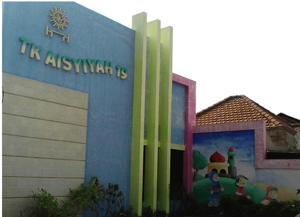
Gambar 4.3 Bangunan TK Aisyiyah 19 Surabaya
