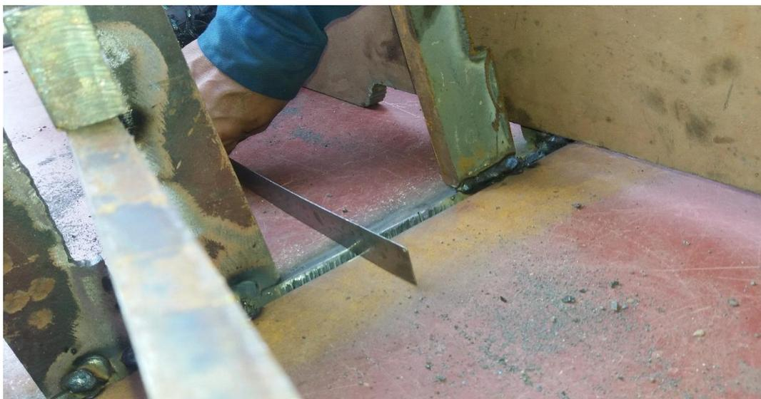
Gambar. Mengukur Kerataan Pada Permukaan Block.
