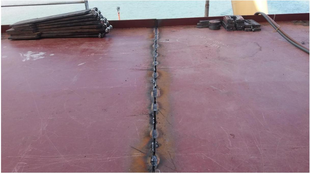
Gambar. Joint Block Tampak Bersih.
