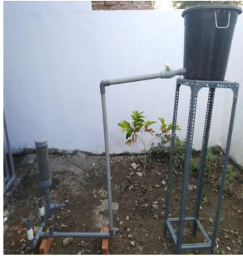
Gambar 4.2 Pemasangan pipa masuk ( input pipa) Sumber : Dokumentasi Pribadi
