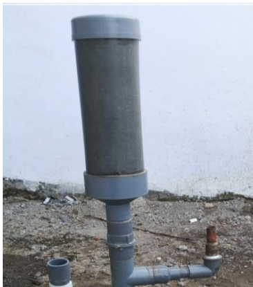
Gambar 4.6 Proses Pemasangan Tabung Udara ke badan Pompa Hidram Doble Power Sumber : Dokumentasi Pribadi
