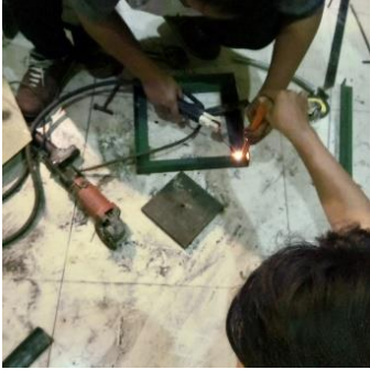
Proses Pembuatan Rangka Penopang Kondensor
