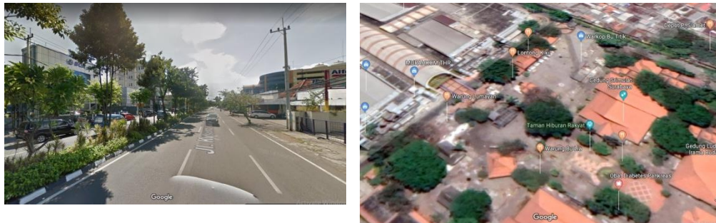
Gambar 4. 7 Jalan Kusuma Bangsa dan Permukiman Sumber : Google Earth
