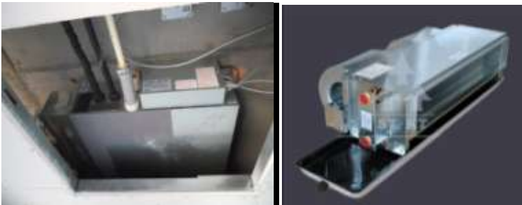
Gambar 2.8. Fan Coil Unit (FCU)
