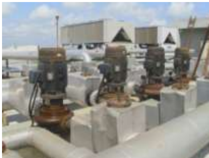
Gambar 2.6. Pompa sirkulasi air dingin
