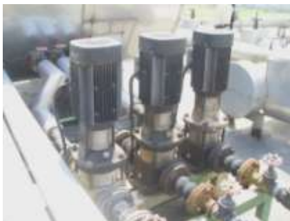
Gambar 2.7. Pompa sirkulasi air panas
