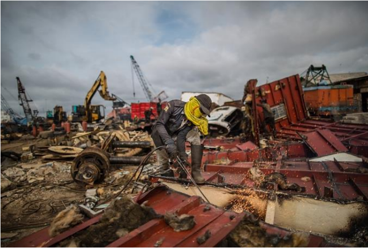
Gambar 2. Pekerjaan pembongkaran kapal di Kalibaru, Jakarta Utara (Sumber: benarnews.org , 2020)
