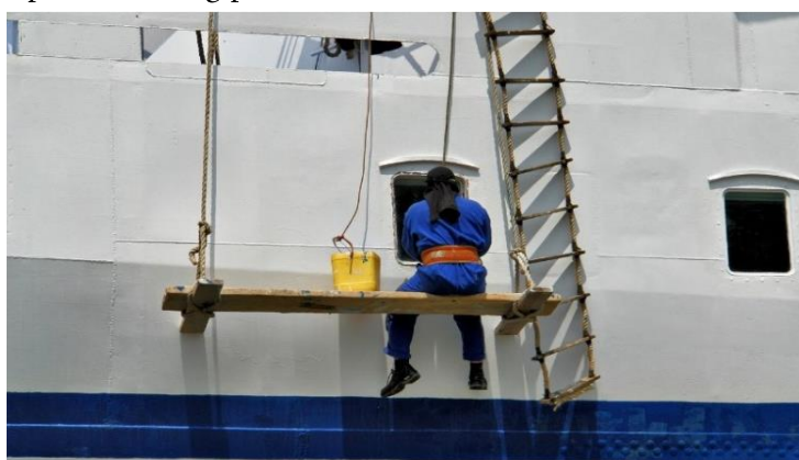
Gambar 7. Proses coating pada lambung
