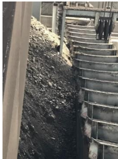
Gambar 1. 2 Longsoran Batubara di main boom scraper (Sumber: Dokumen Peneliti)
