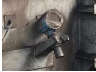
Gambar 4. 6 Pemasangan Sensor FMU41 (Sumber: Endress hauser)
