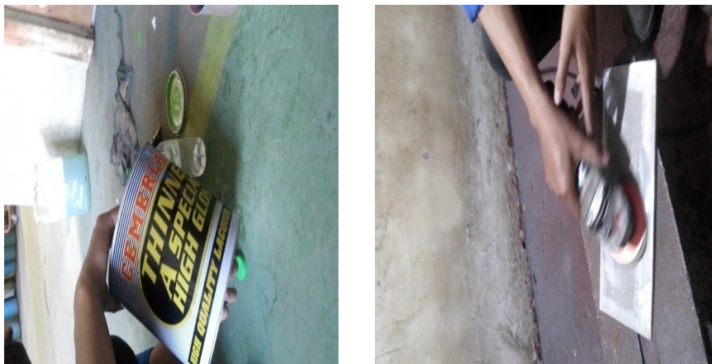
Gambar 3.3 pembersihan permukaan aluminium dengan thinner dan gerinda
