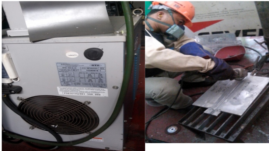
Gambar 3.5 Pelaksanaan proses pengelasan SMAW di kampuh welding
