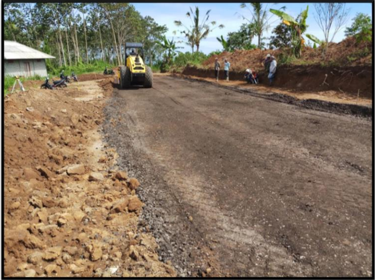
Gambar 2.2.1: Proses pembuatan jalan kerja
