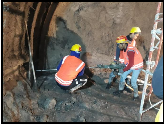
Gambar 2.2.5 : Proses pemasangan rockbolt Sumber : Data Teknik PT Brantas Abipraya (Persero) 2018
