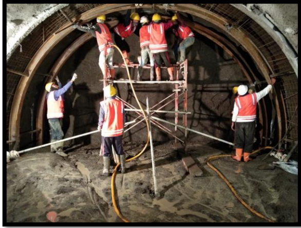
Gambar 2.2.4: Proses pemasangan steel support Sumber : Data Teknik PT Brantas Abipraya (Persero) 2018
