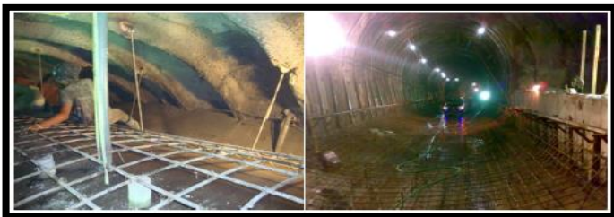
Gambar 2.2.7: Pemasangan tulangan besi lining concrete Sumber : Data Teknik PT Brantas Abipraya (Persero) 2018
