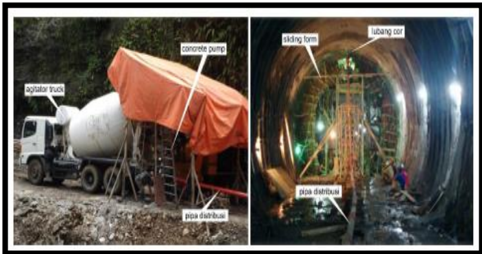
Gambar 2.2.7: Proses pengecoran lining concrete Sumber : Data Teknik PT Brantas Abipraya (Persero) 2018
