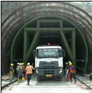
Gambar 4.20: Pelaksanaan pekerjaan pengecoran Sumber : Data Teknik PT Brantas Abipraya (Persero) 2020
