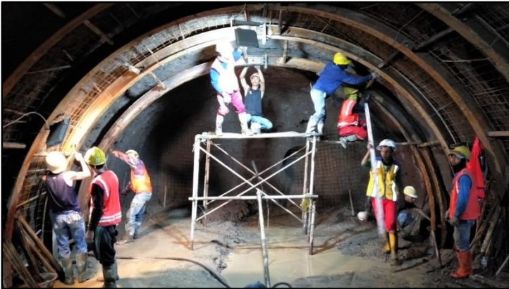
Gambar 4.8: Foto pekerjaan pemasangan baja penyangga Sumber : Data Teknik PT Brantas Abipraya (Persero) 2020
