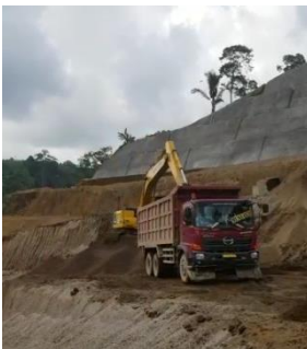
Gambar 4.2: Pekerjaan galian tanah terbuka inlet terowongan Sumber : Data Teknik PT Brantas Abipraya (Persero) 2018
