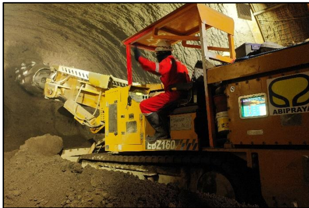
Gambar 4.6.2 : Foto penggalian bagian atas/upper half Sumber : Data Teknik PT Brantas Abipraya (Persero) 2018
