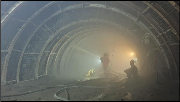
Gambar 4.7.1 : Foto pekerjaan shotcrete 1st layer didalam terowongan Sumber : Data Teknik PT Brantas Abipraya (Persero) 2020
