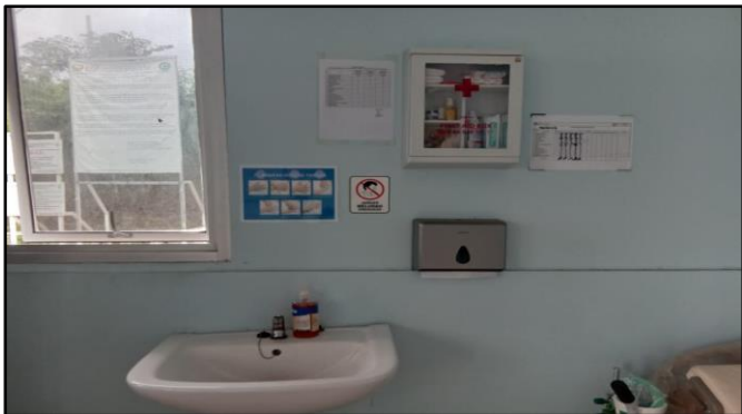
Gambar 4.24.3: Foto bangunan klinik beserta fasilitasnya Sumber : K3 PT Brantas Abipraya (Persero) 2020
