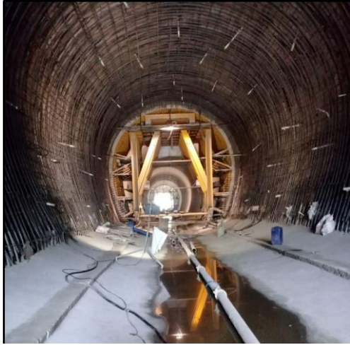
Gambar 4.19 :Foto Pembesian lining concrete Sumber : Data Teknik PT Brantas Abipraya (Persero) 2020
