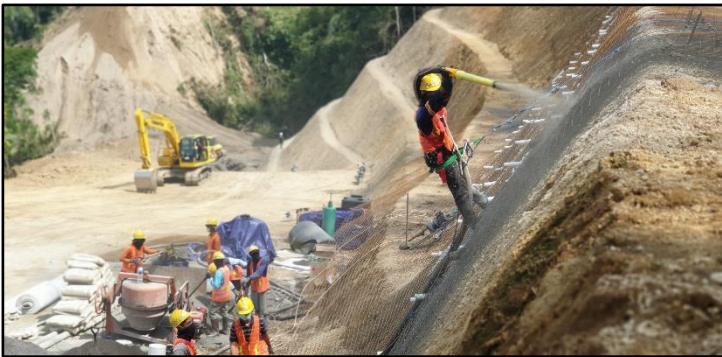
Gambar 4.4.2: Foto pekerjaan proteksi tebing/shotcrete Sumber : Data Teknik PT Brantas Abipraya (Persero) 2018
