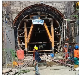
Gambar 4.20: Pelaksanaan pekerjaan pengecoran Sumber : Data Teknik PT Brantas Abipraya (Persero) 2020
