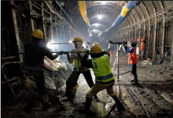
Gambar 4.10: Foto pekerjaan pemasangan rock bolt Sumber : Data Teknik PT Brantas Abipraya (Persero) 2020
