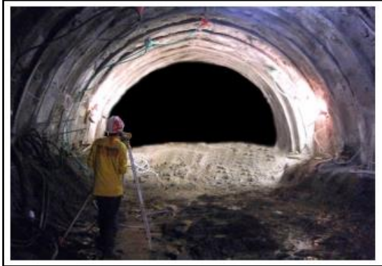
Gambar 4.17.1 : Foto Pengukuran Batas lining concrete Sumber : Data Teknik PT Brantas Abipraya (Persero) 2020
