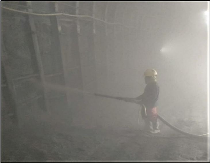
Gambar 4.11: Foto pekerjaan shotcrete 2nd layer didalam terowongan Sumber : Data Teknik PT Brantas Abipraya (Persero) 2020
