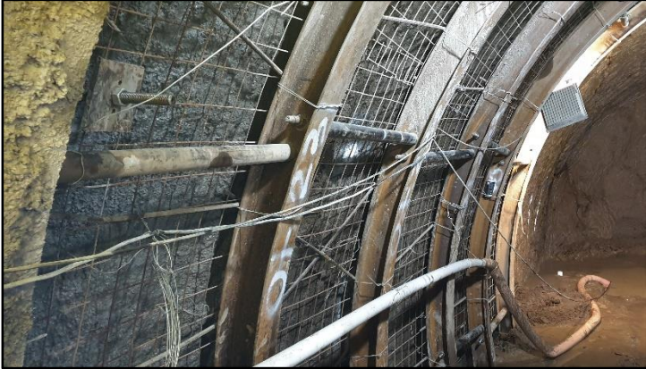
Gambar 4.9: Foto pekerjaan pemasangan wiremesh Sumber : Data Teknik PT Brantas Abipraya (Persero) 2020
