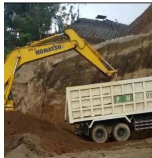
Gambar 4.2: Pekerjaan galian tanah terbuka inlet terowongan Sumber : Data Teknik PT Brantas Abipraya (Persero) 2018
