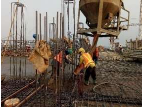
Gambar 4.4.3 Pengerjaan balok dan plat lantai
