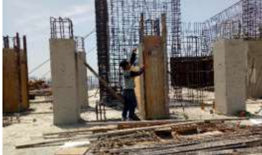
Gambar 4.4.1 pengerjaan kolom Sumber : Pengolahan Data (2020)
