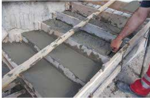
Gambar 4.4.2 Pengerjaan tangga Sumber : Pengolahan Data (2020)
