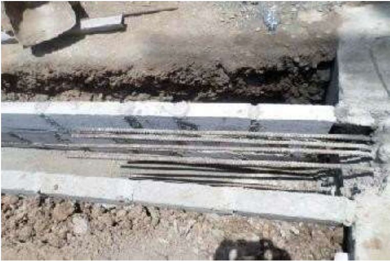
Gambar pemasangan tulangan balok
