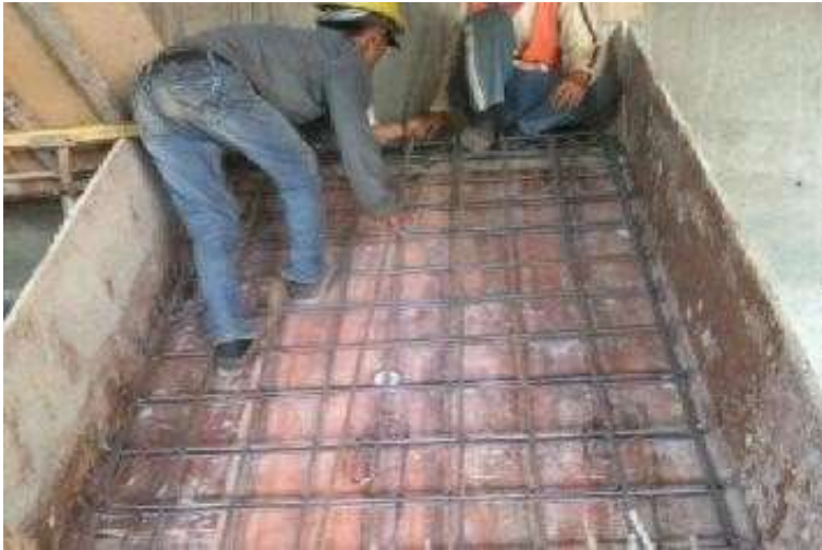
Gambar proses pembesian tangga
