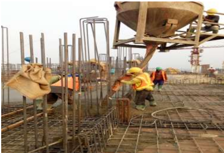
Gambar proses pengecoran balok dan plat lantai
