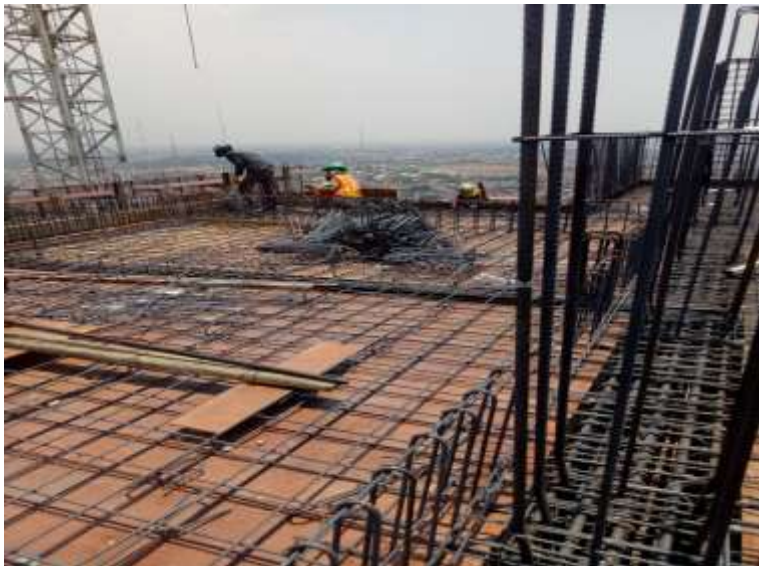
Gambar proses pembesian balok dan plat lantai
