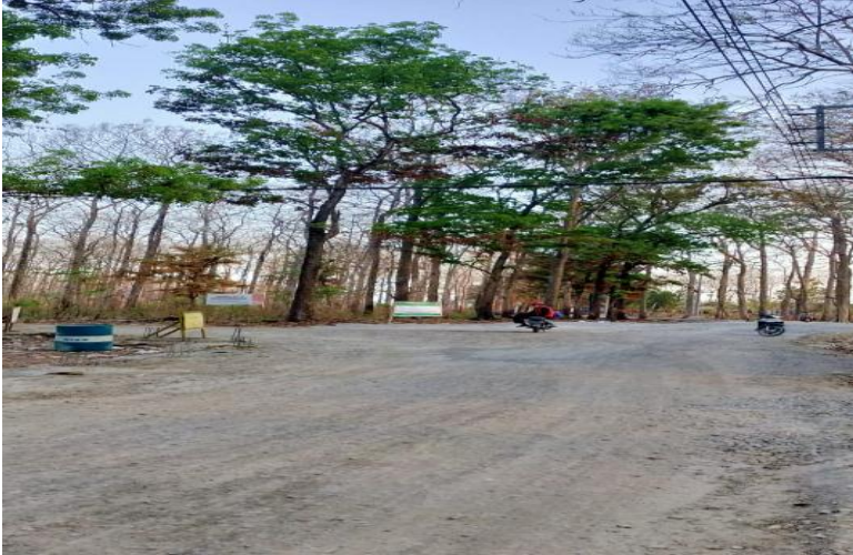
Gambar 2.11 Foto kondisi jalan di Satren Sumber: Data Primer (2019)
