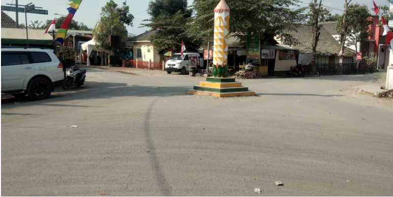
Gambar 2.9 Foto kondisi jalan di pertigaan Ngasem Sumber: Data Primer (2019)
