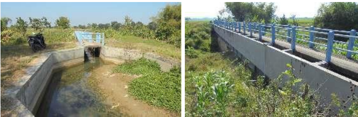
Gambar 4. 8 Bangunan Talang (B.KN.5c) Sumber : Hasil Penelusuran Jaringan Irigasi, 2020
