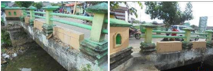
Gambar 4. 13 Bangunan Jembatan Desa (B.KN.2b) Sumber : Hasil Penelusuran Jaringan Irigasi, 2020
