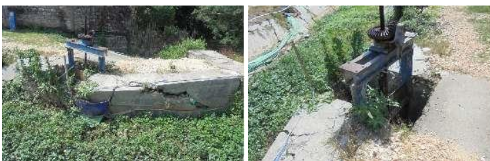
Gambar 4. 11 Bangunan Pintu Pembuang (B.KN.6r) Sumber : Hasil Penelusuran Jaringan Irigasi, 2020
