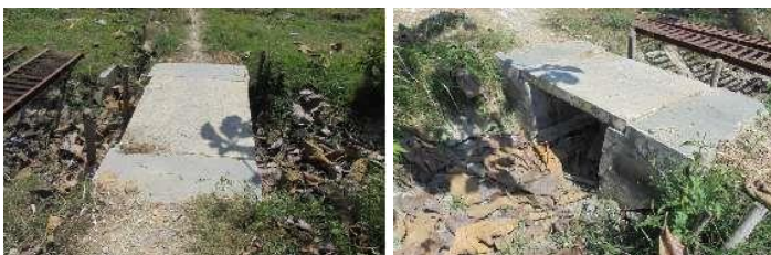
Gambar 4. 12 Bangunan Jembatan Orang (B.BN.2d) Sumber : Hasil Penelusuran Jaringan Irigasi, 2020
