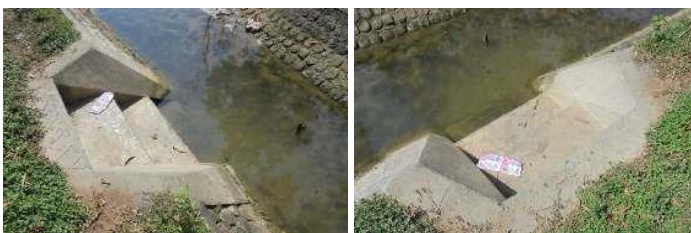
Gambar 4. 14 Bangunan Tempat Cuci (B.NG.1b) Sumber : Hasil Penelusuran Jaringan Irigasi, 2020
