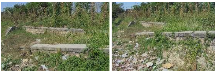
Gambar 4. 15 Bangunan Tempat Mandi Hewan (B.LK.6a) Sumber : Hasil Penelusuran Jaringan Irigasi, 2020
