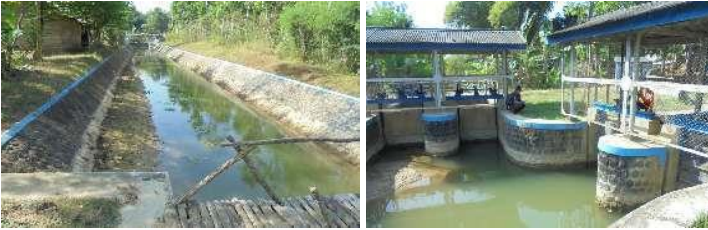
Gambar 4. 5 Bangunan Kantong Lumpur (B.KN.1a) Sumber : Hasil Penelusuran Jaringan Irigasi, 2020
