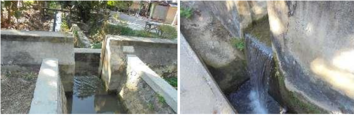
Gambar 4. 6 Bangunan Terjunan (B.LK.1e) Sumber : Hasil Penelusuran Jaringan Irigasi, 2020
