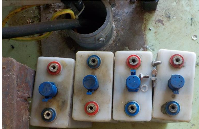
Gambar 4.10 Unit baterai dengan cell dibawah 1V
