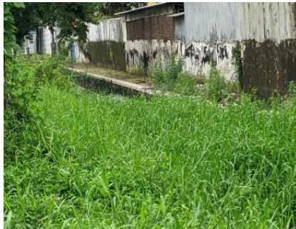
Gambar 1.3 Saluran Existing Sungai Pucang Sidoarjo. Sumber : Dokumentasi Pribadi (2021)
