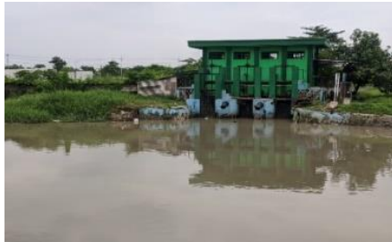
Gambar 1.2 Rumah Pompa Sungai Pucang Sidoarjo. Sumber : Dokumentasi Pribadi (2021)
