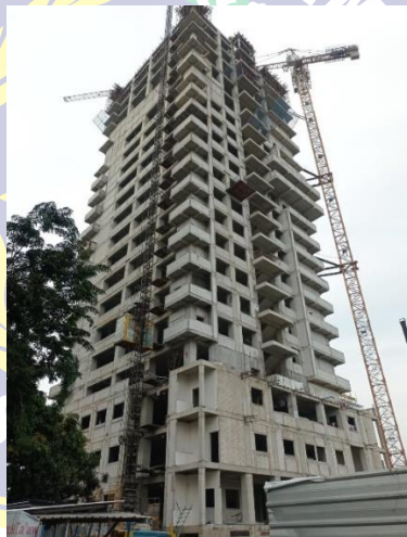
Gambar 1. 3 Pembangunan Gedung At-Ta'awun
