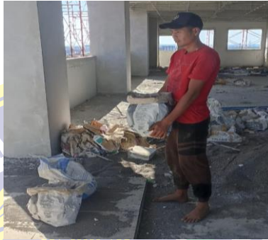
Gambar 3. 6 Pengangkutan Material Sisa Bangunan
