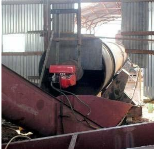
Gambar 18. Mesin pengering skala besar di pabrik pupuk dengan burner berbahan bakar solar.
