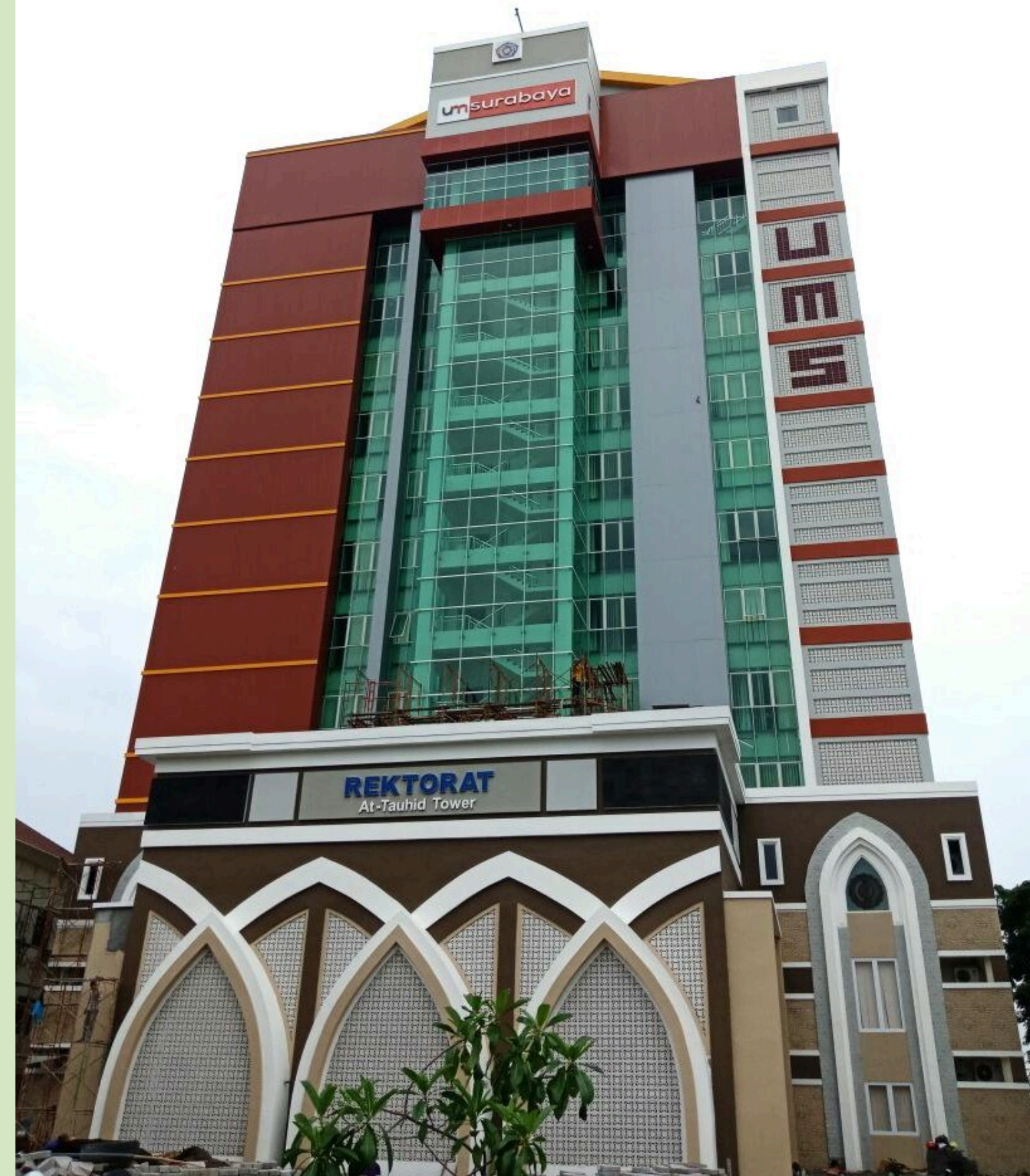
GEDUNG AT-TAUHID LT. 2
