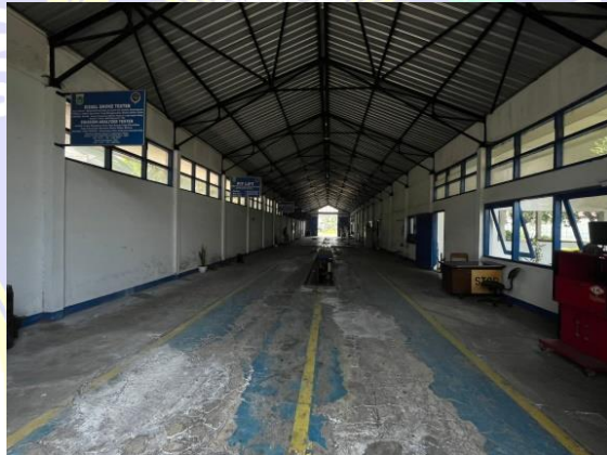
Gambar 3.4 Gedung Pengujian Kendaraan Bermotor (Sumber : Dokumen Pribadi)
