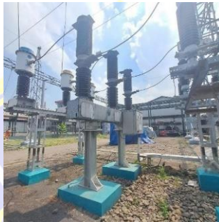
Gambar 2. 6 Gambar fisik PMT 70 kV T/L bay Driyorejo
