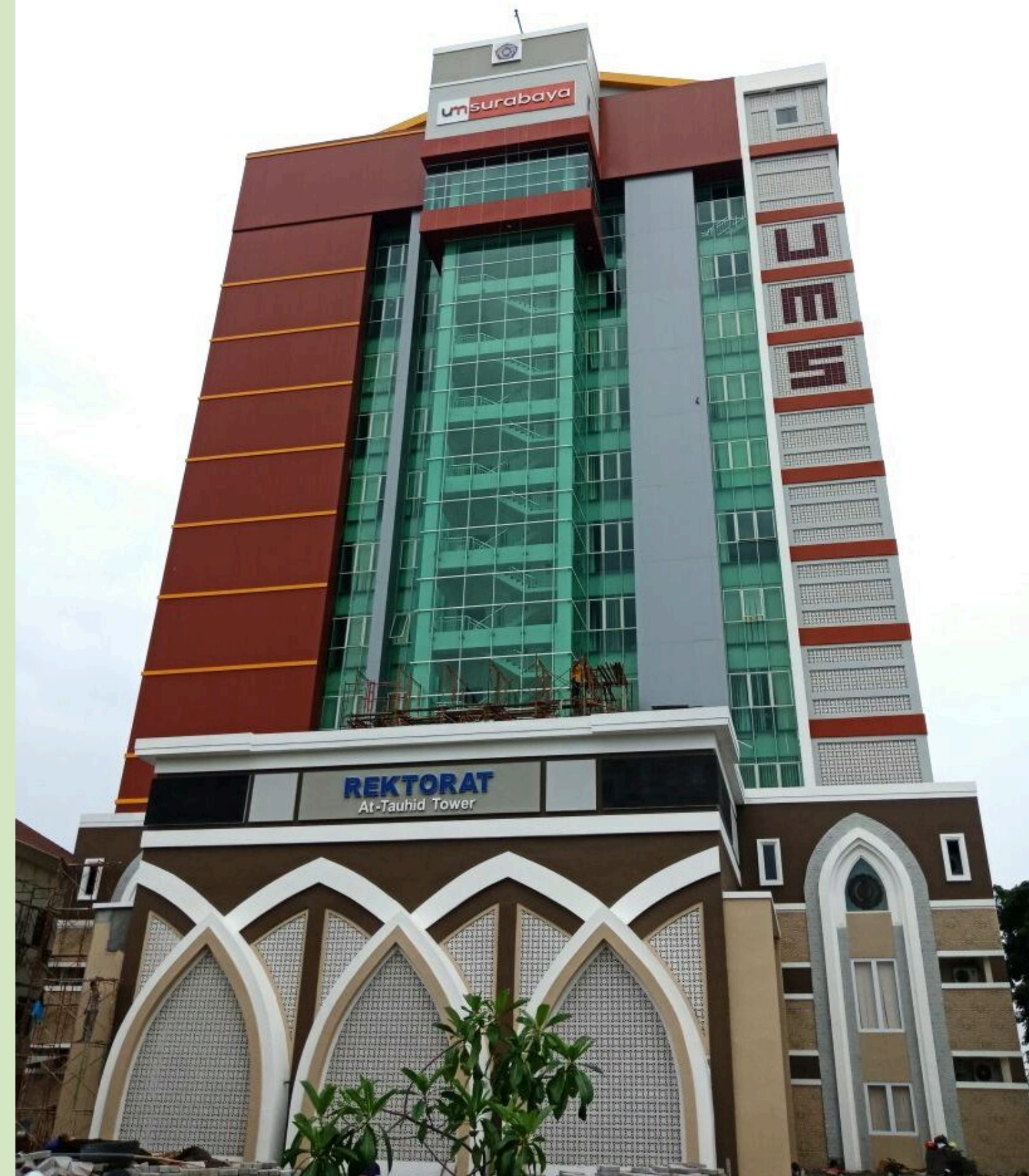
GEDUNG AT-TAUHID LT. 2
