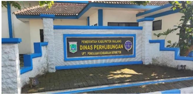
Gambar 3.4 Lokasi Pengujian Kendaraan Bermotor
