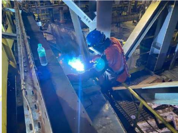
Figure 0-10 Proses pengelasan pada bottom tangki
