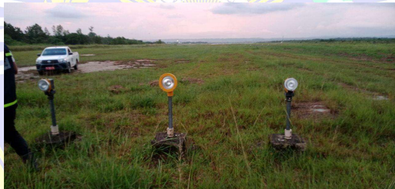
Gambar 2. 27 kondisi eksisting di runway strip
