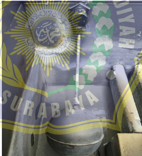
Gambar 2. 4 Pelampung ( float valve )
