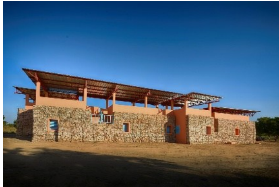
Gambar 2. 27 Tampak Belakang Bangunan ( www.archdaily.com )
