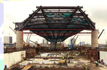
Gambar 2. 21 Penopang Sementara Struktur Atap Selama Konstruksi
