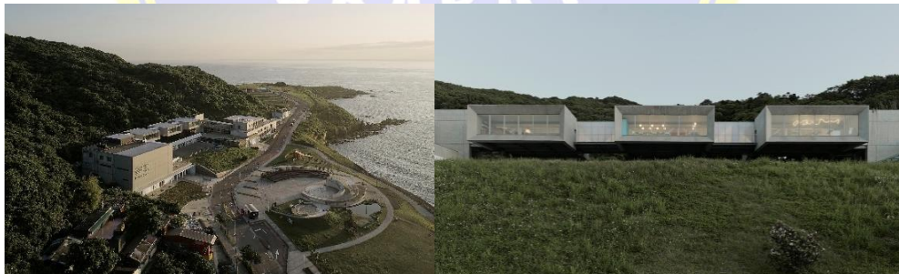
Gambar 2. 103 Tampak Perspektif Eksterior Bangunan Sumber : (www.archdaily.com, 2019)
