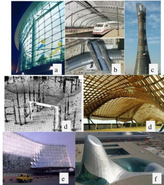
Gambar 2. Contoh Tipologi Cangkang Bentuk Bebas : (a) Permukaan minimal, (b) Scale Translation Surface , (c) Scale Revolution Surface , (d) Bentuk dari digantung, (e) Ruled Surface , (f) NURBS Surface
