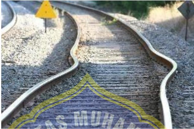
Gambar 2.2 *Buckling* pada rel kereta api
