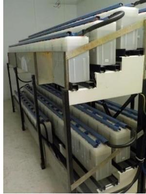
Gambar 2.11 Baterai UPS di Sub Station
